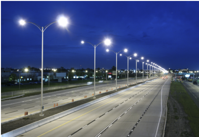
Lichtmasten in de openbare ruimte
